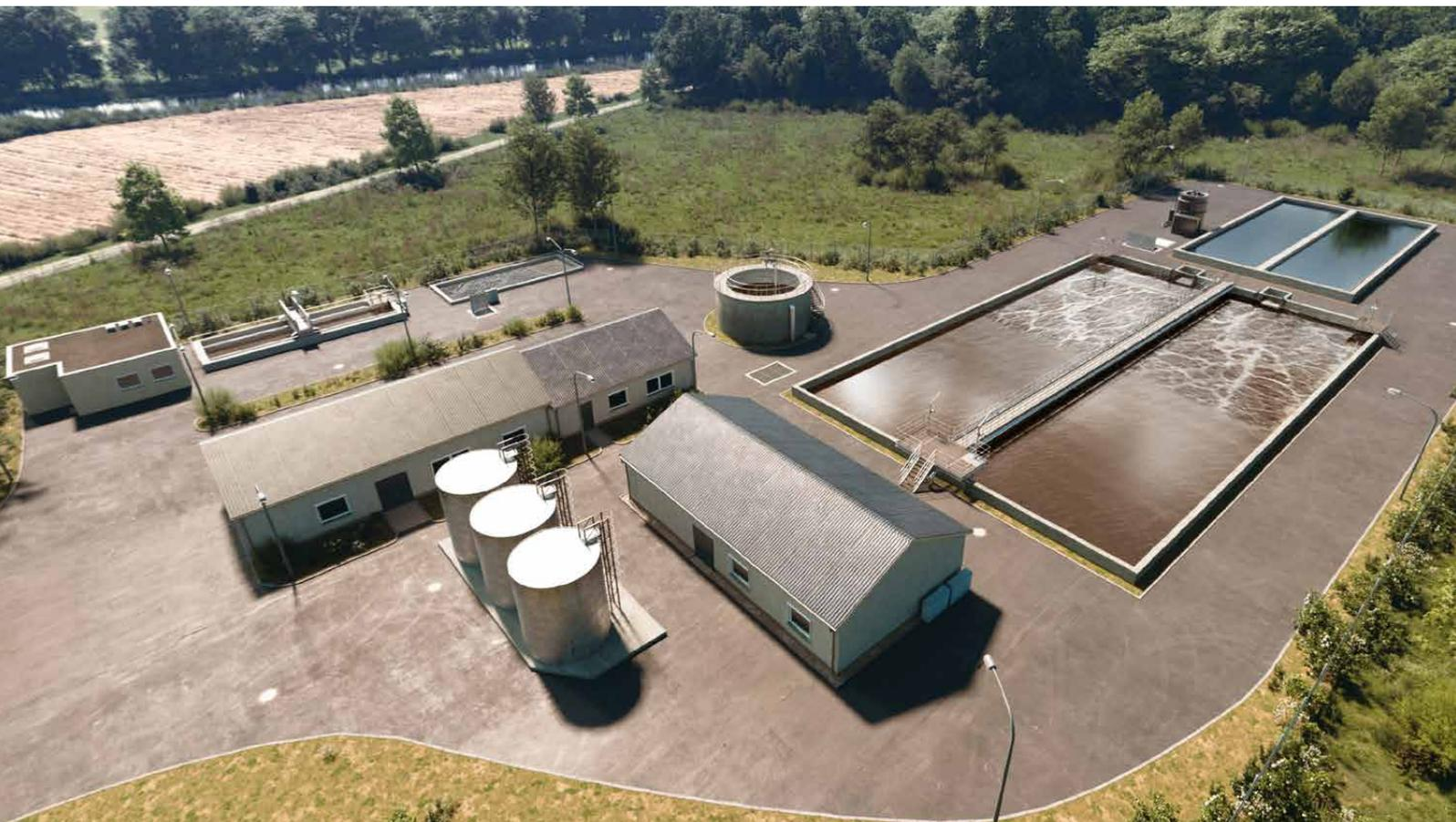
Verfahrenstechnisch bedingt fallen im Kläranlagenprozess verschiedenste Schlammarten an. Diese Schlämme werden für den weiteren Anlagenprozess in dafür geeigneten Schlammsilos oder Schlammstapelbehältern zwischengelagert. In Abhängigkeit des Klärprozesses werden die Schlammschichten regelmäßig durchgemischt.
