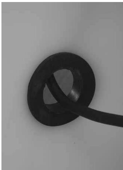
10. ábra: Kábelátvezetés
