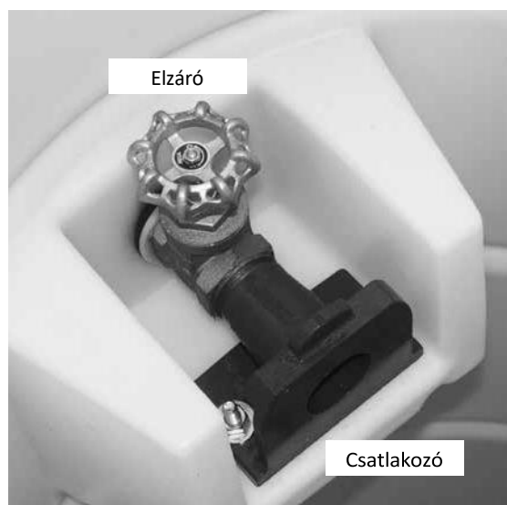
7. ábra: Nyomóvezeték csatlakozás
