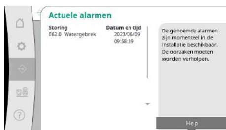
Fig. 55: Menupunt Communicatie→Alarmen→Actuele alarmen
