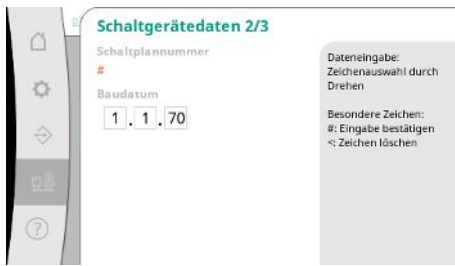
Fig. 104: Menüpunkt System → Wartung → – Schaltgerätedaten 2/3
