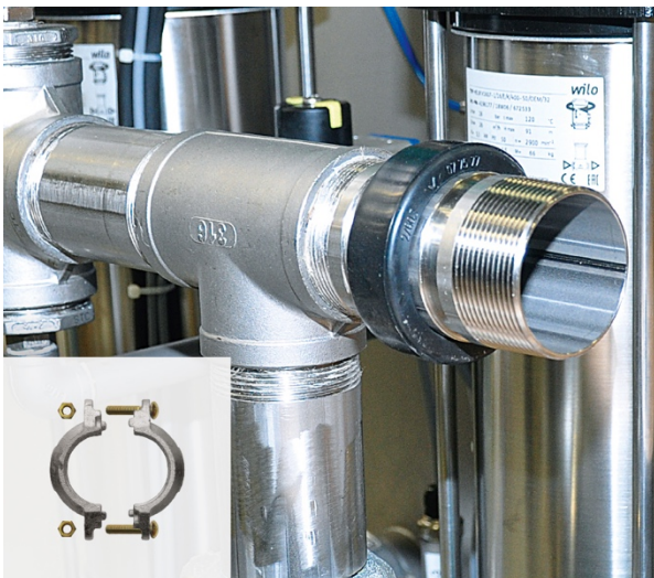
3. Übergangsstück einfügen.
