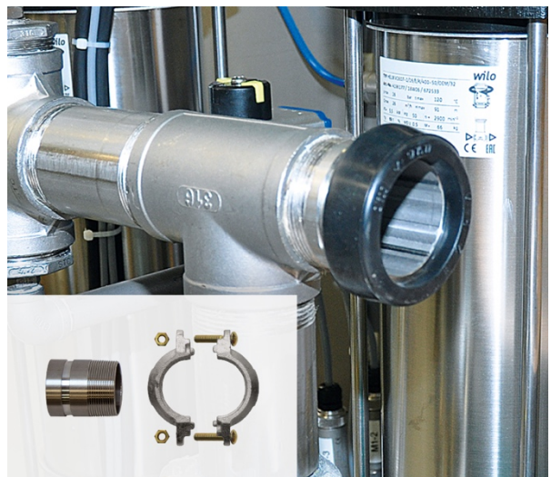
2. Vorgefetteten Dichtungsring aufstecken.
