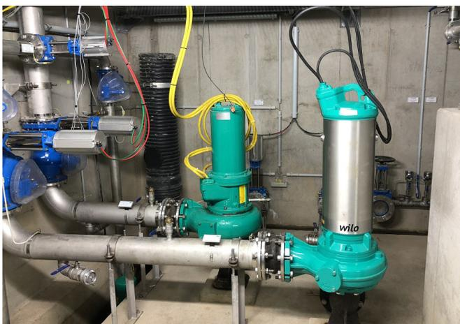
*Durch den Einsatz der Wilo-Rexa SOLID-Q mit Nexos-Intelligenz beim Umbau des Pumpwerks Buchbusch konnten Verstopfungen stark reduziert werden, sodass die Service-Einsätze auch minimiert wurden. Die Betriebskosten konnten deutlich gesenkt werden.*
