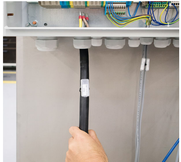
Kabel in Regelung führen.
