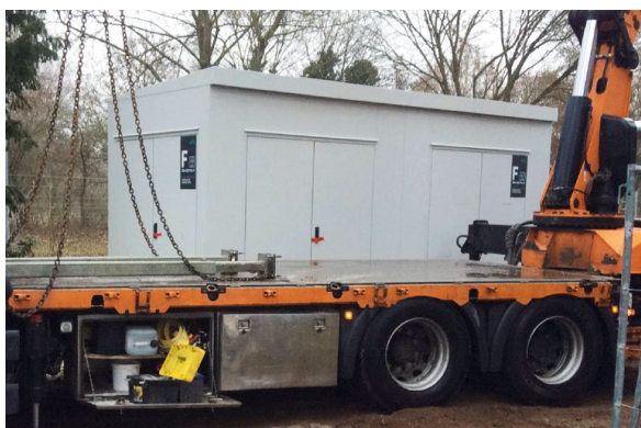
3. Transportösen und Traversen sind entfernt.
