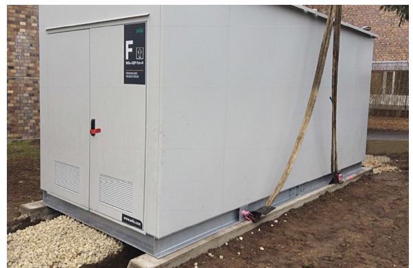
2. Wilo-GEP Cubion auf Fundament abgeladen.
