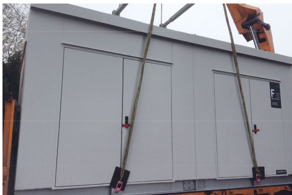
1. Abladen mit Lkw-Ladekran möglich, Befestigung seitlich an mitgelieferten Transportösen und oben zum Schutz des Dachüberstandes an Traversen angehängen.
