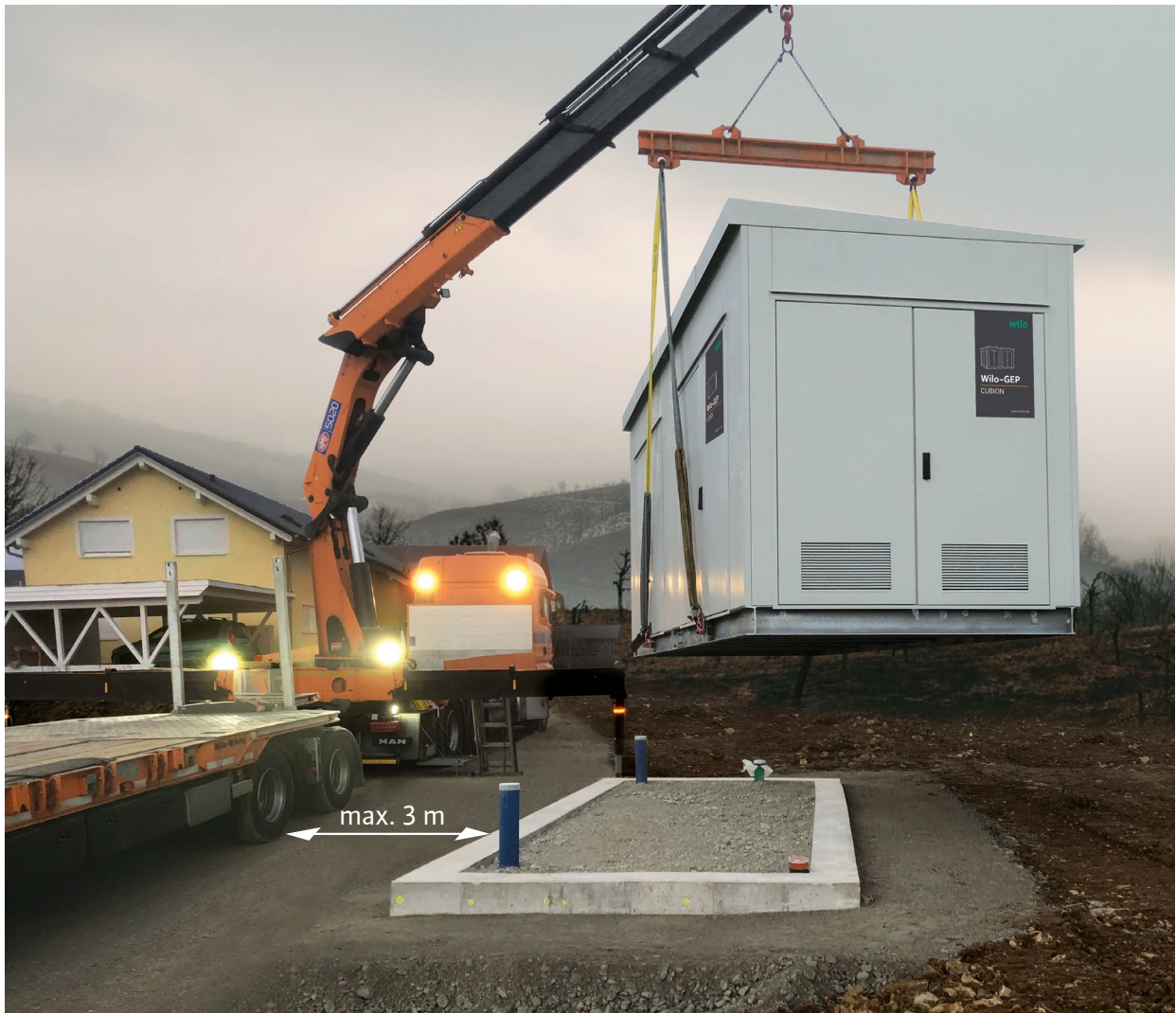
Aufstellung eines Wilo-GEP Cubion.
