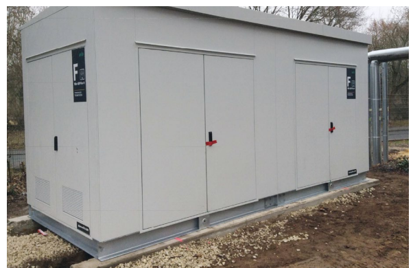
4. Abladung beendet. Die Auflageflächen sind umlaufend zu verfüllen, um Kältebrücken zu minimieren.
