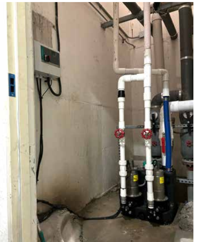
현풍 아파트 현장 기존 오배수 패키지를 철거하고, 기존 자리에 콤팩트한 사니컷을 설치하여 공간확보
