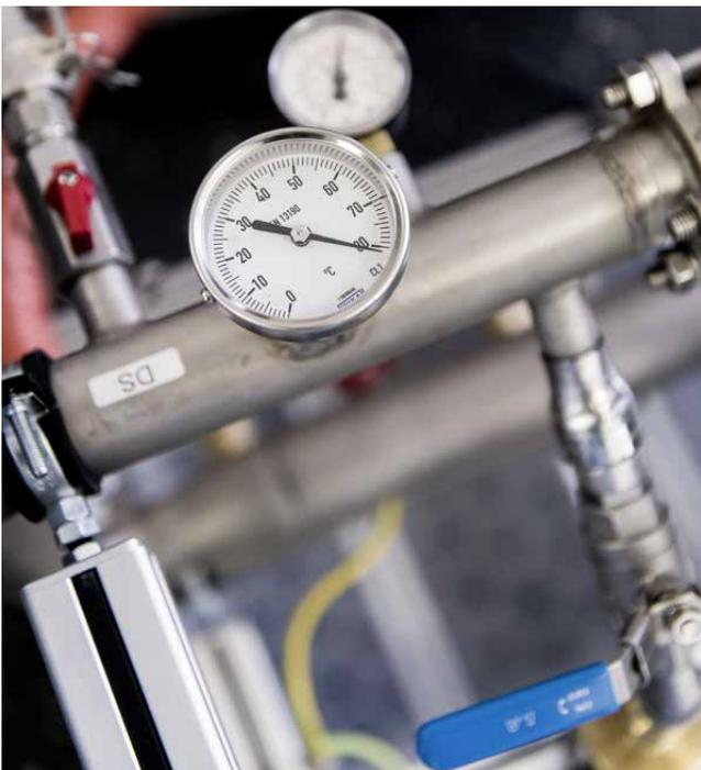
Im thermischen Desinfektionsprozess werden alle medienberührenden Oberflächen für mehrere Minuten auf mehr als 70 °C erhitzt. Die Hitze durchdringt Biofilme besser und tötet diese erfolgreicher ab als Chemikalien. Zudem werden die aktiven und inaktiven PSA-Bakterienstadien vollständig eliminiert.
