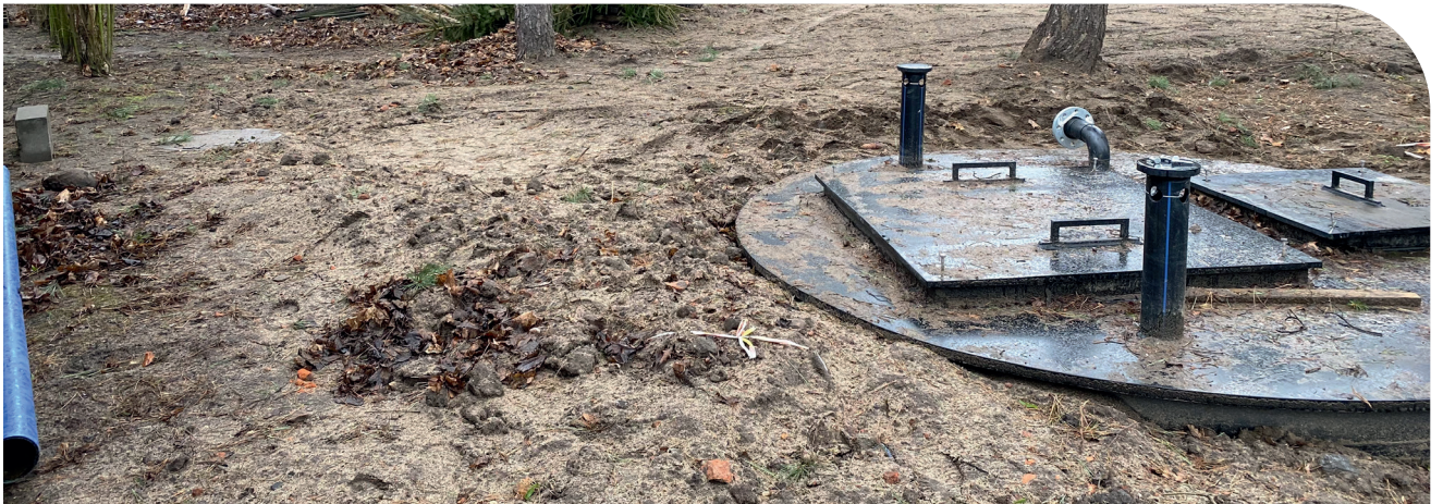
Rys. Zwieńczenie wykonane z płyty ze wzmocnieniem z ociepleniem i wyposażone w pokrywy włazowe oraz kominki wentylacyjne i króćce technologiczne
