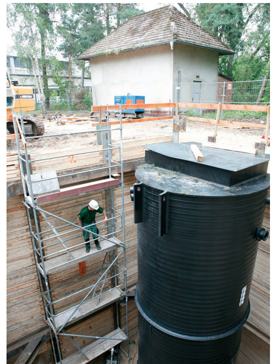
Rys. Posadowienie komory podziemnej z tworzywa PEHD
