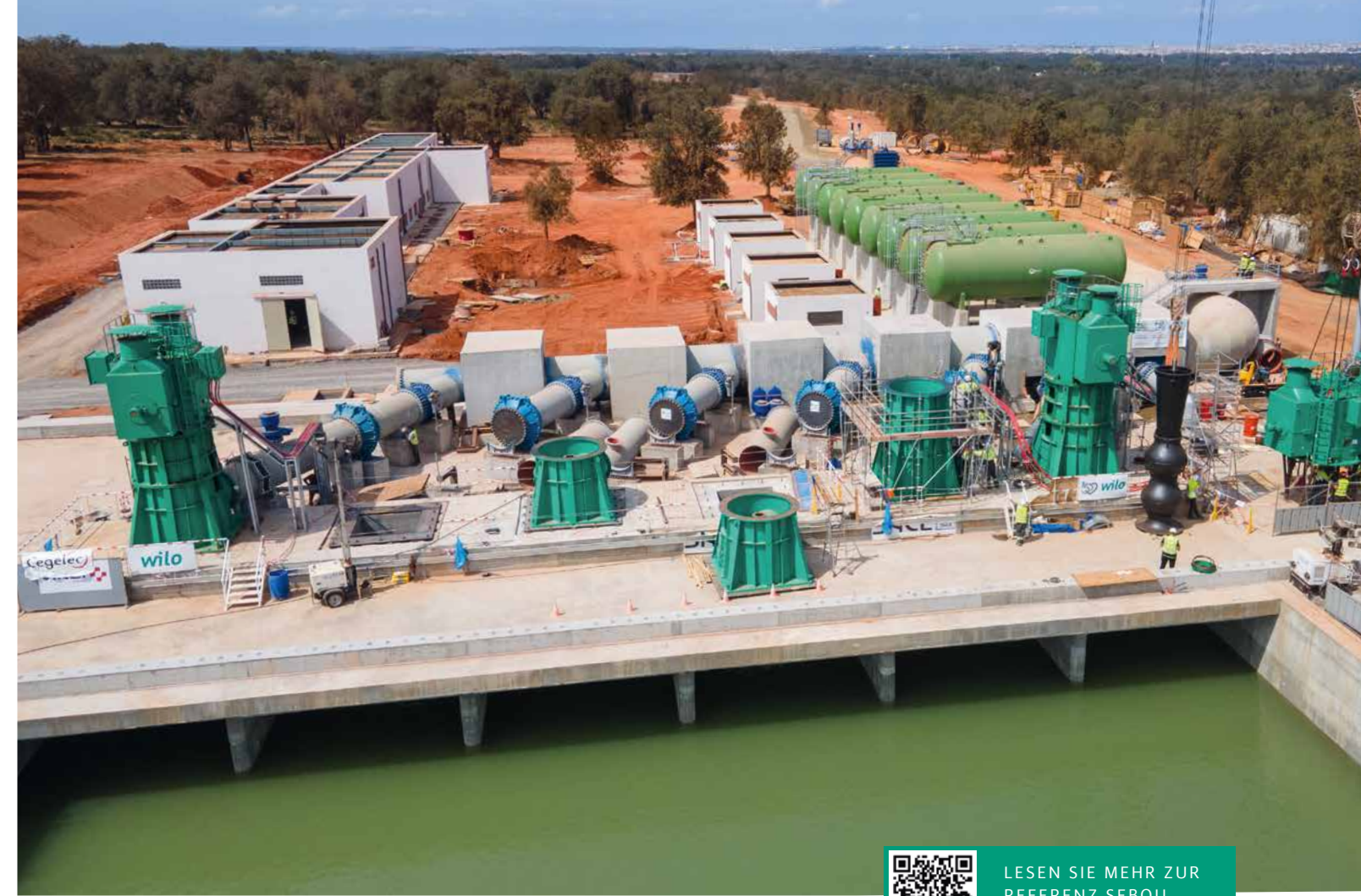
Zwölf Vertical Turbine Pumps verbinden den Sebou-Sperrdamm mit dem Sidi-Mohamed-Ben-Abdellah-Damm und sichern damit die Trinkwasserversorgung der Großstädte Rabat und Casablanca.
