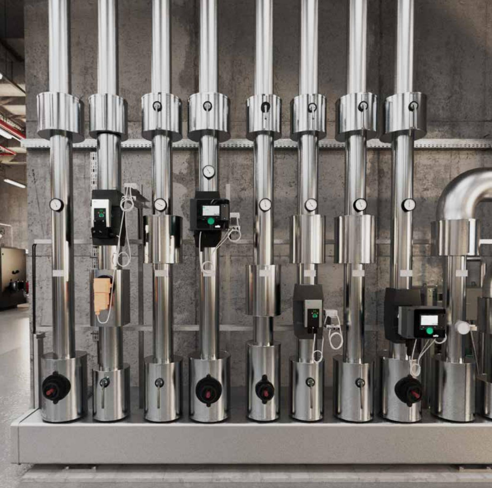
**Wilo Italia srl** a completamento della propria offerta di pompe e sistemi di pompaggio, aggiunge la proposta di **valvole di intercettazione, valvole di ritegno, giunti antivibranti e filtri** per gli impianti HVAC e Centrali Termiche.
