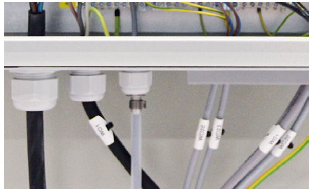
7. Das Edelstahlrohr sollte mit geeignetem Gleitmittel versehen werden und in die Durchführung geschoben werden.
