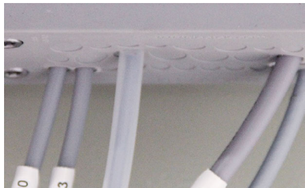
7. Das Edelstahlrohr sollte mit geeignetem Gleitmittel versehen werden und in die Durchführung geschoben werden.
