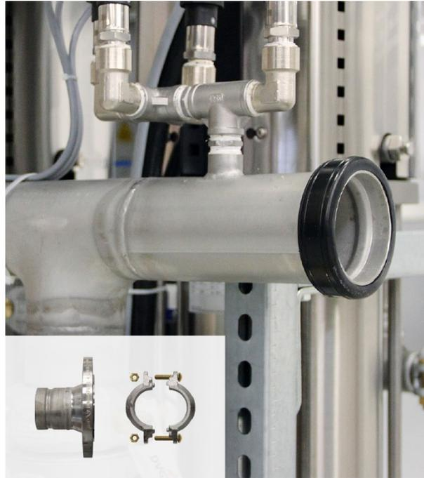
2. Vorgefetteten Dichtungsring aufstecken.
