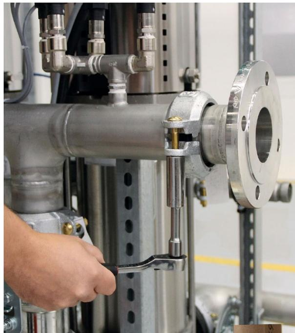
4. Kupplung auflegen und festziehen. Die Nuten der Kupplung greifen in die Rollnutnaht.
