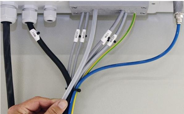
8. Weitere Möglichkeit zur Einführung des Sensorkabels in die Regelung.
