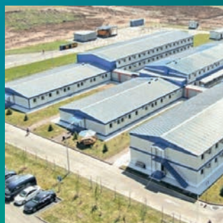
Hôpital Noursultan, Kazakhstan – Des pompes Wilo pour un nouvel hôpital
