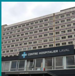
Centre hospitalier de Laval (53) – Suppression, circulateurs intelligents et économies d'énergie avec Wilo-Energy Solutions.
