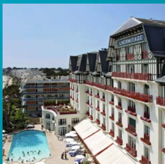
Hôtel Barrière l'Hermitage – La Baule (44) – Efficacité et gains énergétiques des surpresseurs Wilo-SiBoost Smart Helix VE.
