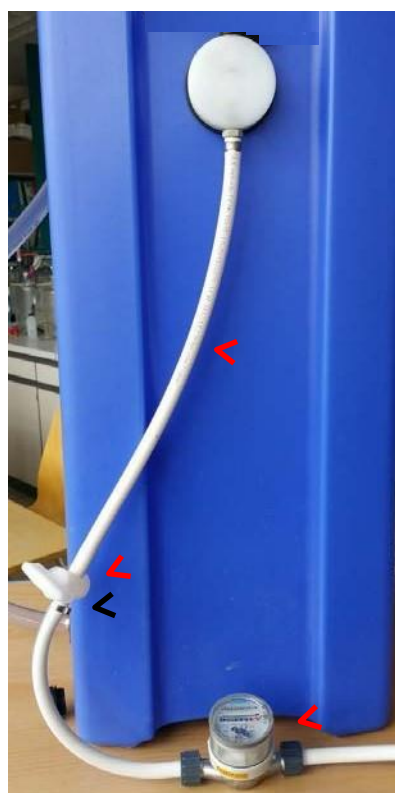
Рисунок 10: Зв'язок між PAUL® та резервуаром для фільтрованої води (набір 2) – що поставляється з PAUL® та як змонтувати лічильник води
