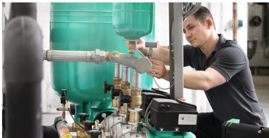
❖ Фото 3. Подключение УПД через гибкие соединительные шланги
