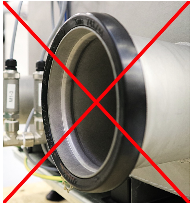
ACHTUNG! Falsch montierte Dichtung.
