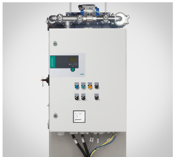
Kabelstrang gebündelt in Regelung.
