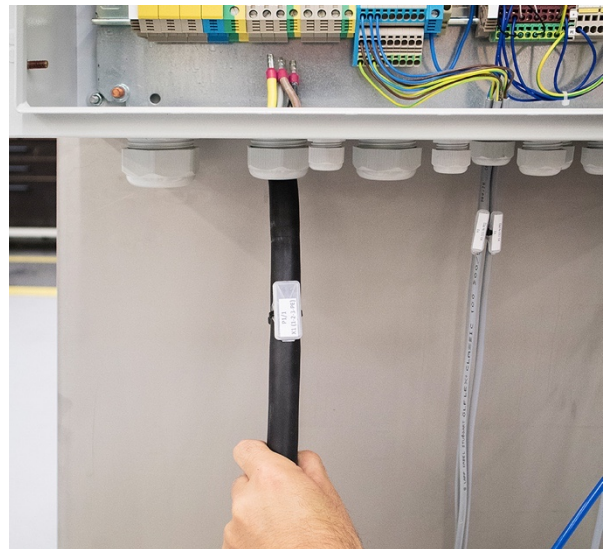
Kabel in Regelung führen.
