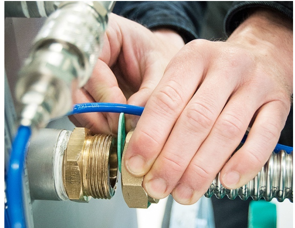
Anschluss Überströmleitung an Behälter.
