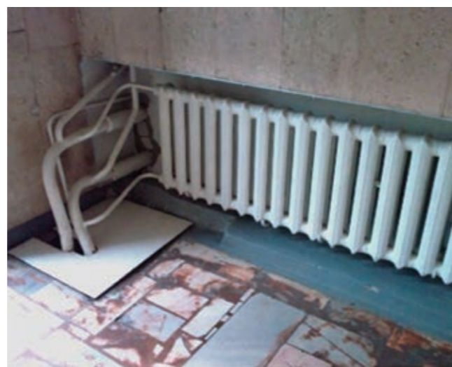
Рис. 8. Пример «похмельной» обвязки радиатора
