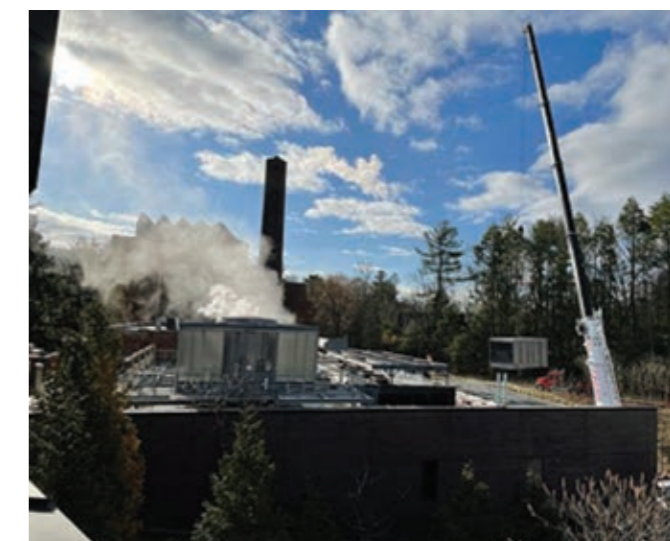
Рис. 3. Строительство новой центральной электростанции в колледже Уэллсли в Массачусетсе началось в декабре 2020 года; этап ввода в эксплуатацию начался в мае 2021 года
