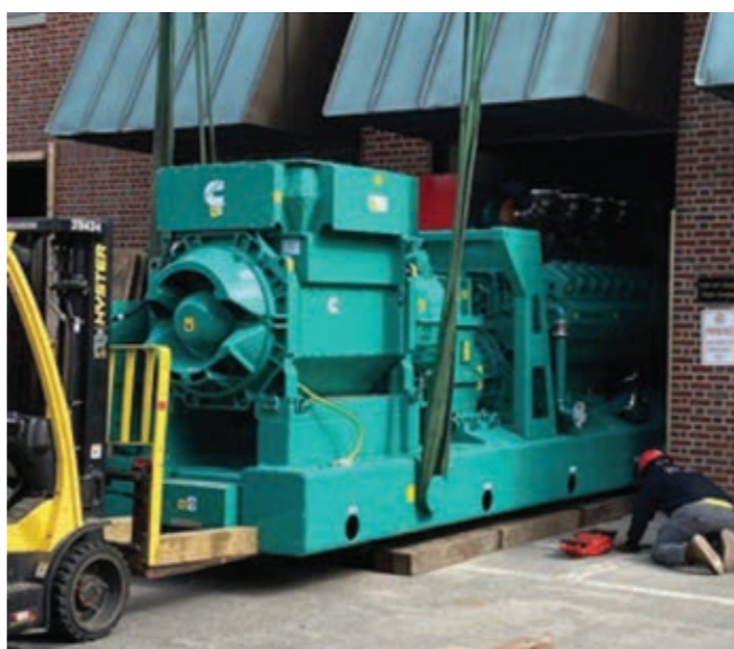
Рис. 1. Генератор Cummins, работающий на природном газе, перемещен на новую электростанцию peaking в колледже Уэллсли в Массачусетсе
