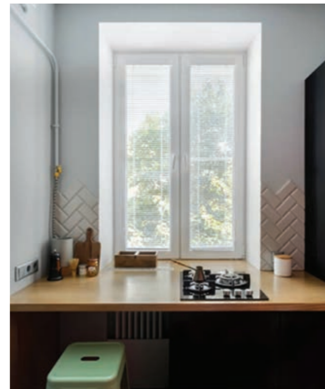
Столешница-подоконник перекрывает поток теплого воздуха от прибора отопления к окну
