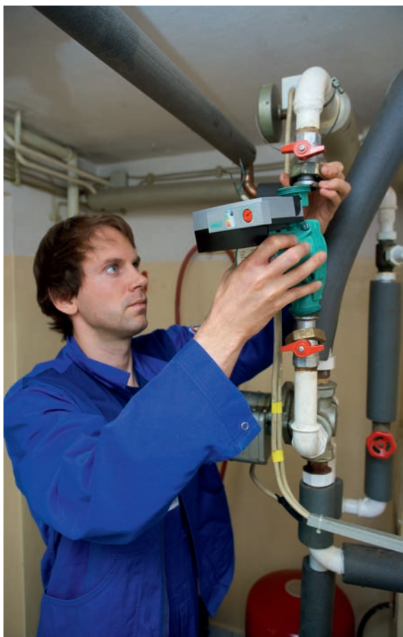
Bild 4 • Auszubildender beim Einbau der Hocheffizienzpumpe.
