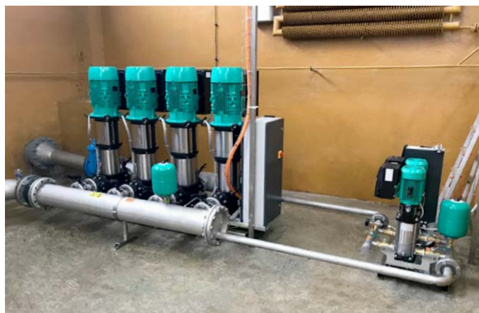
Stan po modernizacji
