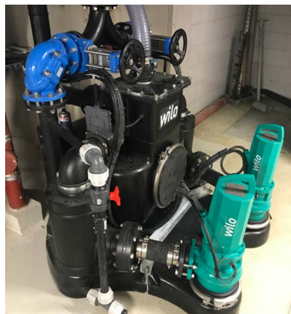
Stan po modernizacji
