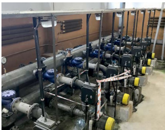
Stan przed modernizacją
