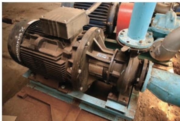
котельной старый сетевой насос типа Д заменили мощным консольным агрегатом GRUNDFOS NK 250-500/485, а вместо питательного ЦНСГ установили вертикальный девятиступенчатый GRUNDFOS CR 32-9. В котельной № 17 – соответственно NB 100-200/203 и CR 10-10. В остальных трех вместо сетевых насосов типа К установили GRUNDFOS NB 50-160/140 и NB 50-160/136.
