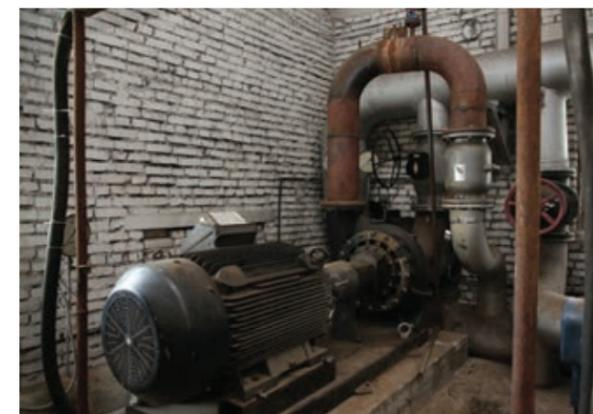
своей способности создавать высокий напор агрегаты этой серии широко используются в системах повышения давления, а также на подпитке водогрейных и паровых котлов.
