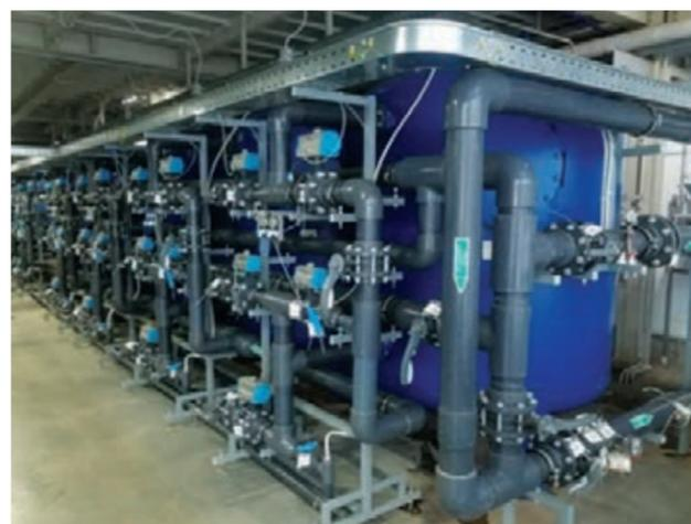
Установка фильтрации и обезжелезивания
