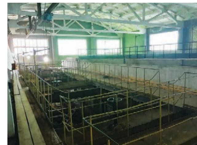
вода из р. Ипуть забирается в насосной первого подъема и подается на фильтровальную станцию, где установлены циклоны и фильтры грубой очистки. Перед включением насосов 1-го подъема для удаления воздуха и создания разрежения во всасывающем трубопроводе запускаются вакуумные насосы.
