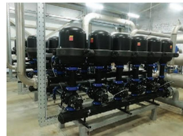
Блок фильтров с пневмоклапанами
