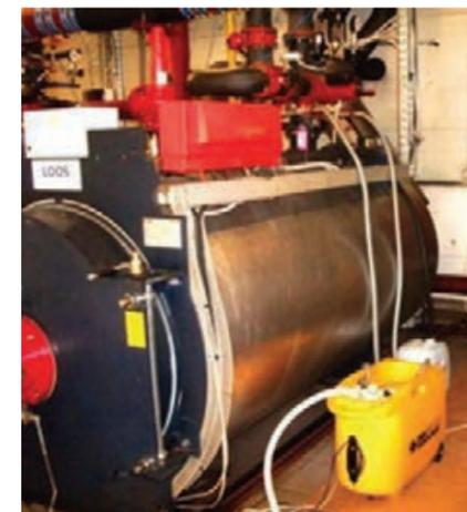
Рис. 3. Химический бустер малой мощности, используемый для химической промывки котла LOOS
