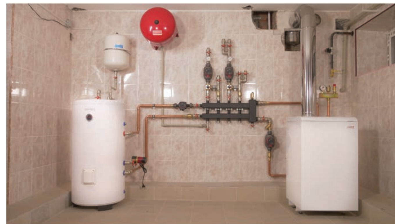
Котельная на цокольном этаже
