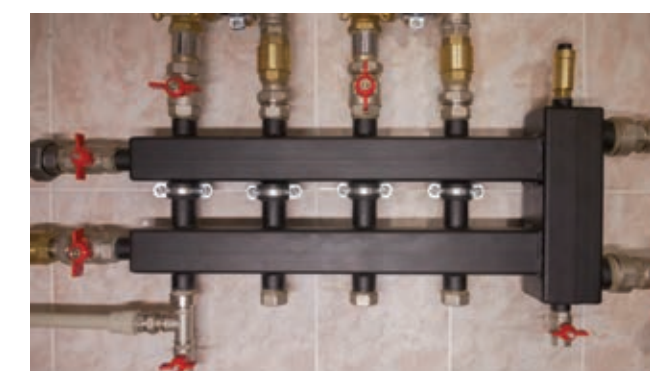
Коллектор с гидравлическим разделителем (гидрострелкой)
