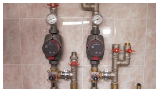
Насосы ALPHA3 в контурах теплого пола и радиаторного отопления
