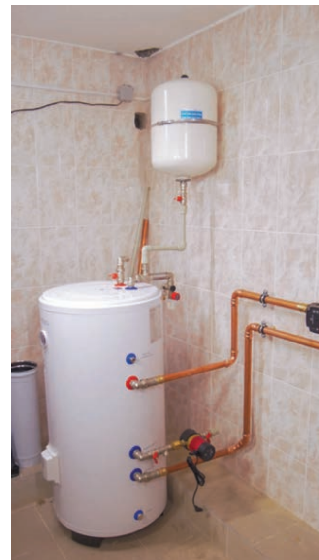
Бойлер системы ГВС с циркуляционным насосом GRUNDFOS COMFORT 15-14 BT PM
