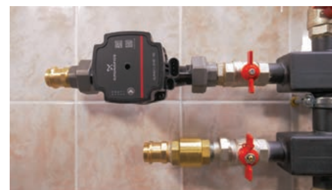
Насос GRUNDFOS ALPHA1 L 25-60 установлен в контуре загрузки бойлера
