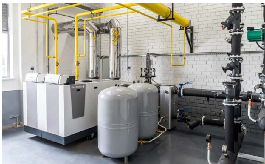
❖ Крышная котельная в городе Егорьевске (Московская область) с котлом C 630 Eco , оборудованном самой современной автоматикой Diematic Evolution
