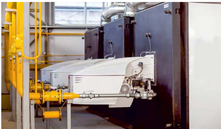
❖ Стальные котлы серии CABK в киржачской котельной
