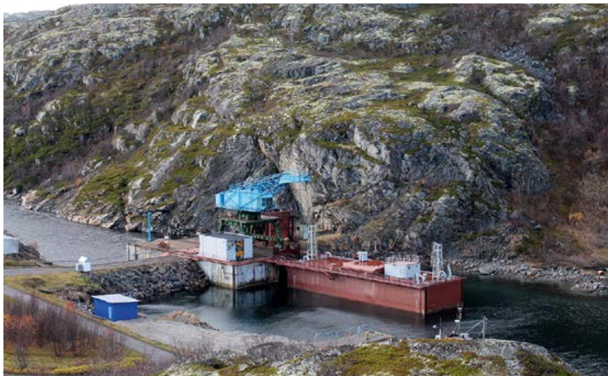
... Экспериментальная Кислогубская ПЭС (0,54 млн кВт·ч в год) в Баренцевом море
