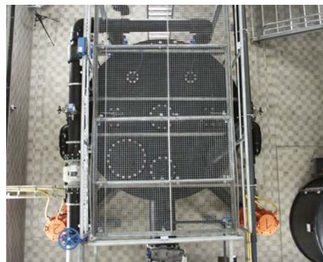
Tłocznia z PEHD z pomostem roboczym
