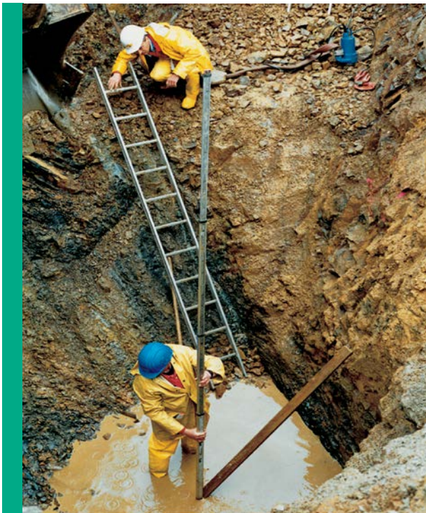
Solidne pompy typu KS stosuje się najczęściej do przetłaczania cieczy z wykopów i szybów.
