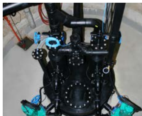
Tłocznia PEHD w studzience betonowej
