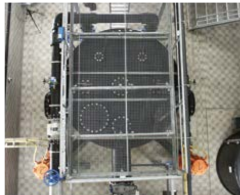
Tłocznia z PEHD z pomostem roboczym
