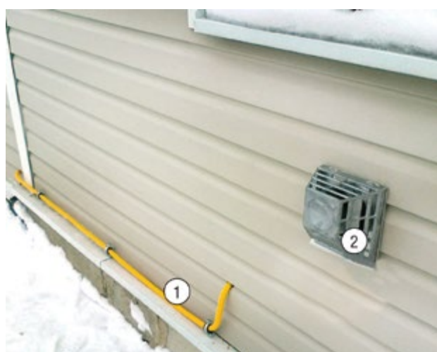
Рис. 2. Газовая труба к конвектору – 1 и оголовок коаксиального газохода – 2 на фасаде дома
