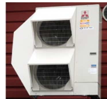
Рис. 2. Тепловой насос воздух-воздух
