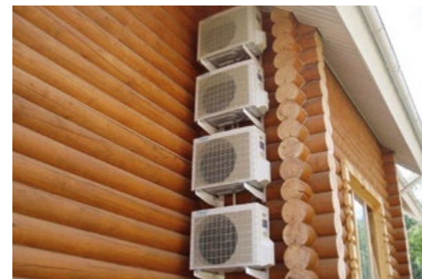
Рис. 2. Расположение наружных блоков сплит-системы кондиционирования
