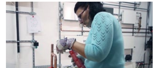
В рамках семинара был проведен наглядный эксперимент, который позволил сравнить две самые распространенные технологии монтажа медных трубопроводов: мягкую пайку и пресс-технологии (соединение трубопроводов с помощью пресс-фитингов)
