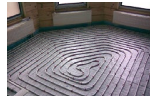
Рис. 2. Использование теплого пола в комбинации с радиаторным отоплением
