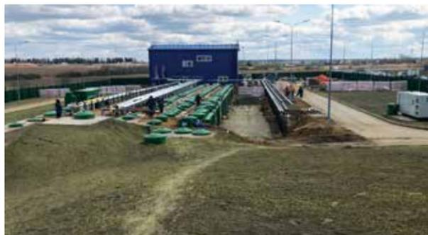
Также необходимо было оборудовать центр дезинфицирующим рекреационным резервуаром и системами предварительной очистки для дальнейшего безопасного перекачивания стоков в городскую канализационную систему.
