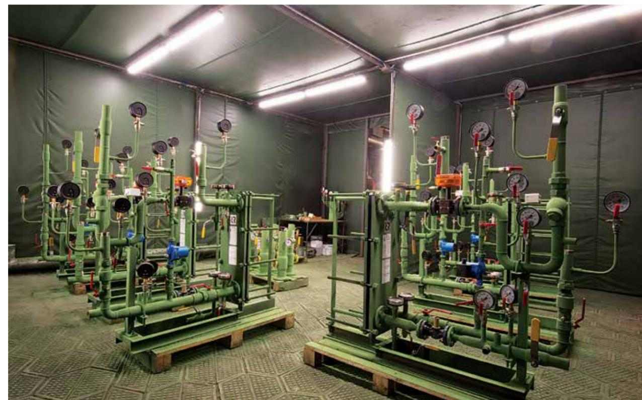
Автоматизированные тепловые пункты заводского исполнения «ТЭМ® АИТП»
