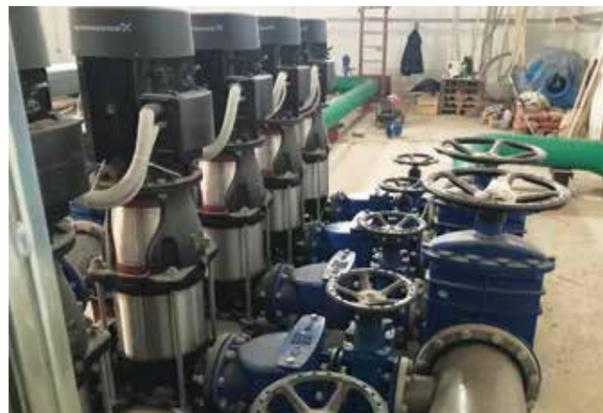
Практическая реализация проекта началась в 2019 г. Одним из требований, выдвинутых эксплуатирующей организацией – ООО «Карелводоканал», стал высокий уровень автоматизации и диспетчеризации работы. На первом этапе была выполнена модернизация станции второго подъема. В отремонтированном здании установили модульную автоматическую станцию на базе пяти вертикальных многоступенчатых центробежных насосов GRUNDFOS CR 125–2–1 производительностью до 160 м<sup>3</sup>/ч каждый: три рабочих и два резервных.
