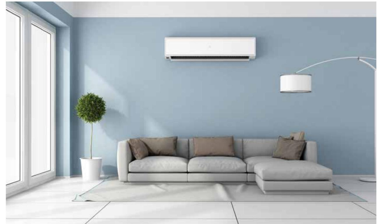
Одна из энергосберегающих функций, применяющаяся на инверторных сплит-системах, например, Panasonic, управляет работой кондиционера в зависимости от нахождения в помещении движущихся людей и (или) животных. При активации этой функции кондиционер регистрирует движение в помещении и в случае отсутствия движения переходит в режим пониженной производительности, а при регистрации движения вновь начинает работать в прежнем режиме.
