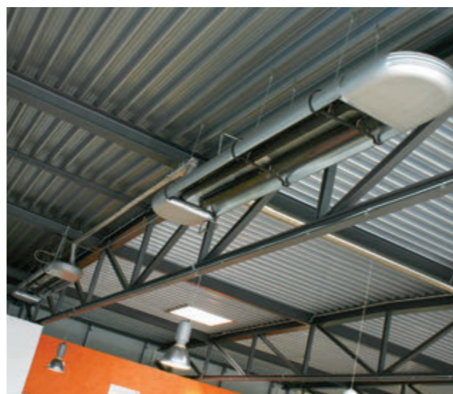
Установки газового лучистого отопления тип Ohtima Plus фирмы KÜBLER
