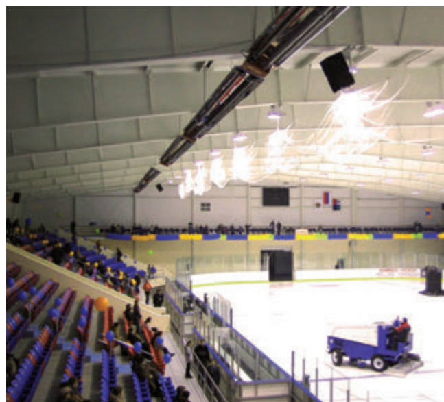
Газовые инфракрасные излучатели темного типа PANRAD (FRACCARO)
