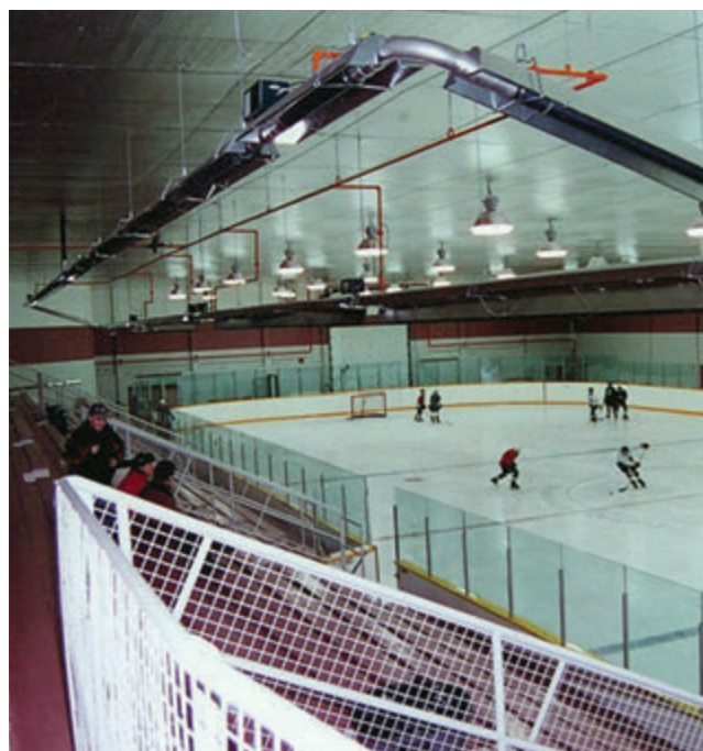
Fultonvale Арена. Обогрев газовыми инфракрасными излучателями GoGaS темного типа
