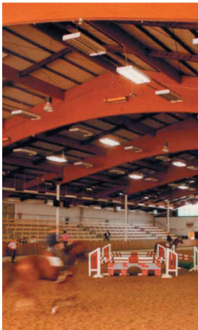
Отопление в конном зале (GoGaS)
