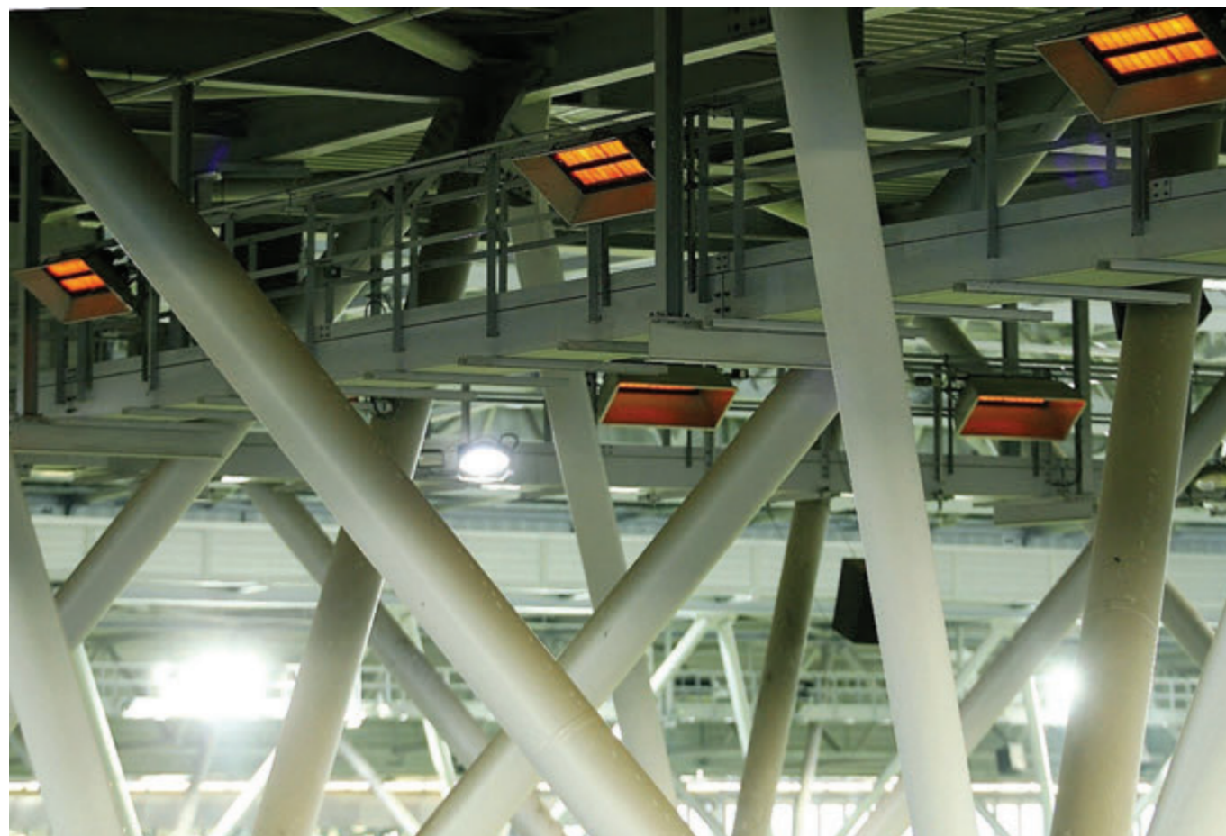
ESPRIT-Арена. Обогрев газовыми инфракрасными излучателями GoGaS светлого типа
