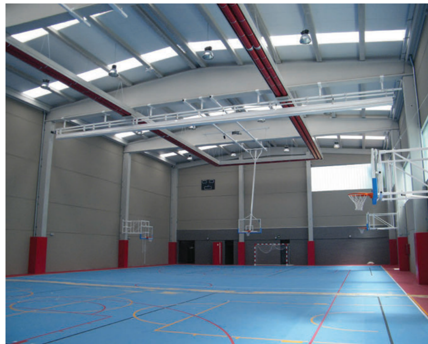
Газовые инфракрасные излучатели ленточного типа GIRAD (FRACCARO)
