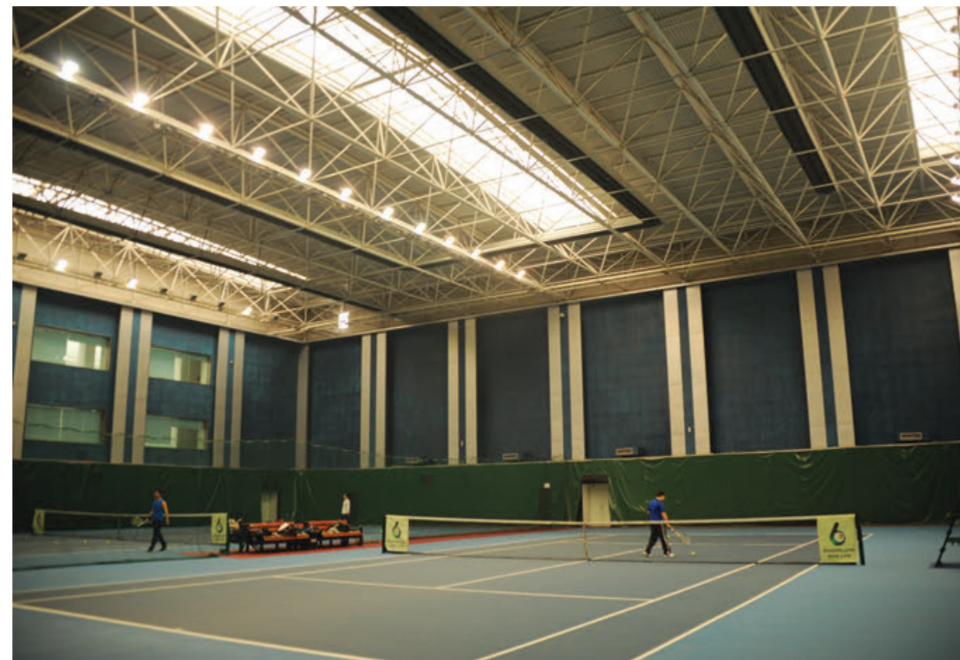
Отопление корта инфракрасными газовыми ленточными излучателями EUCERK (CARLIEUKLIMA S.r.l.)
