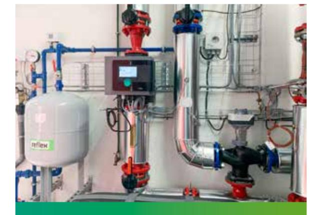
Nutzung der Wärme aus Druckluftherzeugung am Produktionsstandort in Laval, Frankreich
