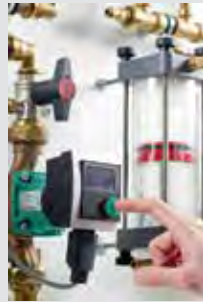
Hızlı elektrik bağlantısı sağlayan Wilo Connector
