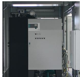
Innenansichten mit integrierter Trinkwasser-Trennstation.
