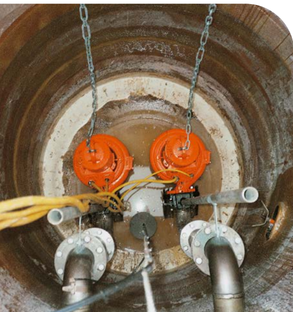
Przepompownia z pompami zainstalowanymi w mokrej studzience
