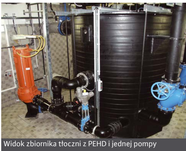
Tłocznia z PEHD (komora zewnętrzna podziemna również z PEHD) ze schodami zabiegowymi
