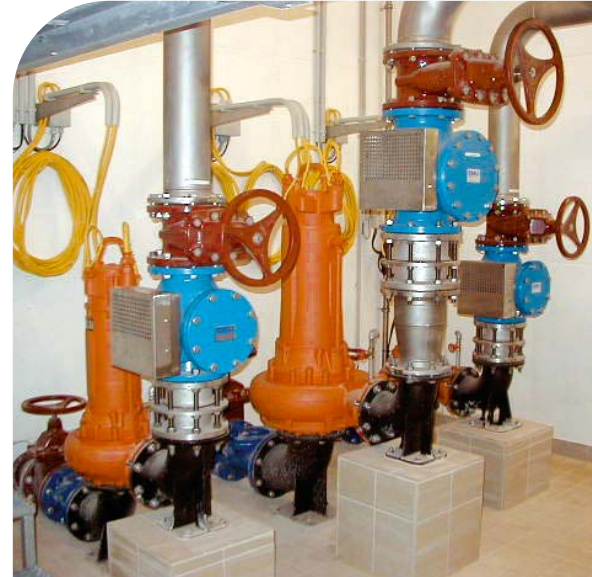
Pompy i armatura wyposażone w układ sterowania
