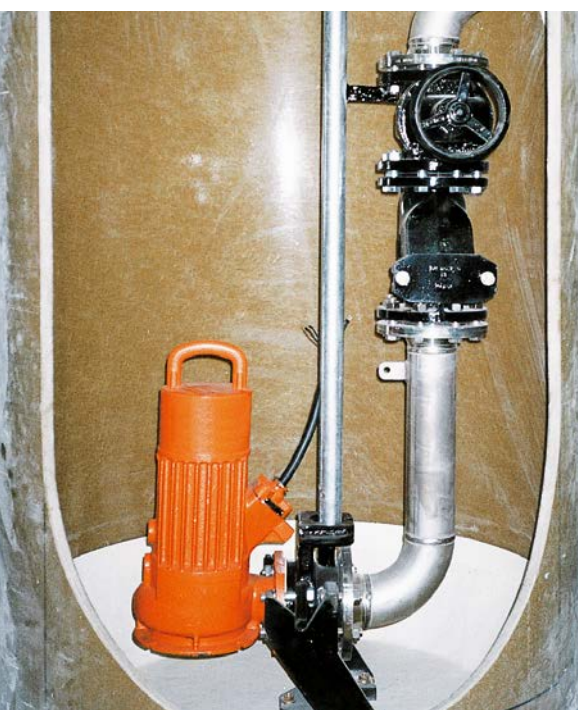
Przepompownia – stopa sprzęgająca i prowadnice rurowe ze stali nierdzewnej
