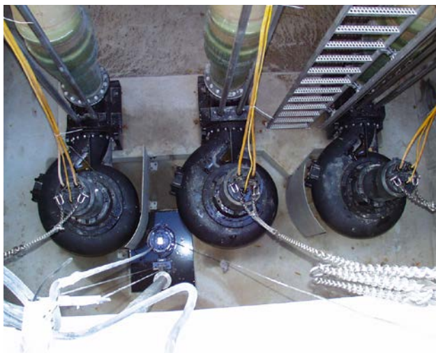
Pompy w ustawieniu suchym, pośrodku mała pompa odwadniająca
