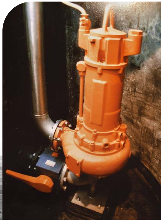
Pompy z wewnętrznym zamkniętym chłodzeniem olejowym
