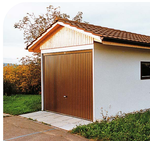
Budynek pomocniczy z dachem spadzistym i drzwiami wahadłowymi
