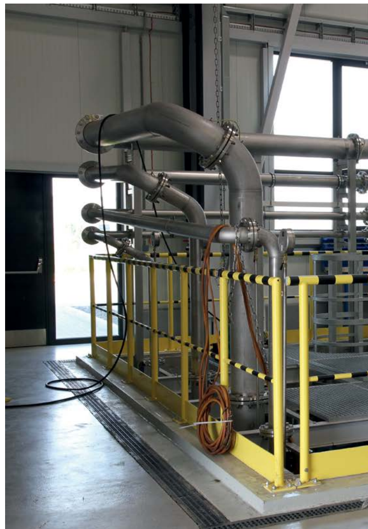
Stacja prób pomp do ścieków i wody zanieczyszczonej w siedzibie Wilo Polska.
