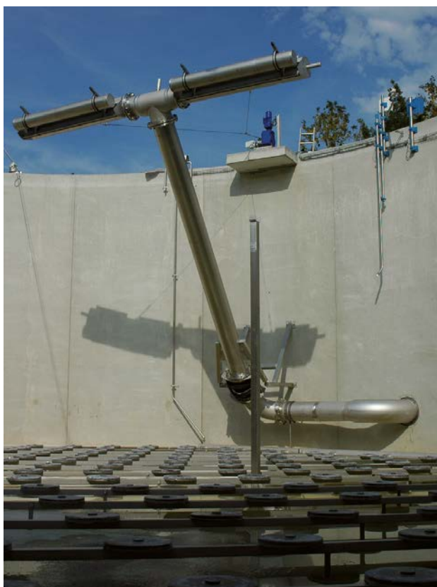
Dekanter w połączeniu z dyfuzorami dyskowymi Wilo-Sevio ELASTOX®-D
