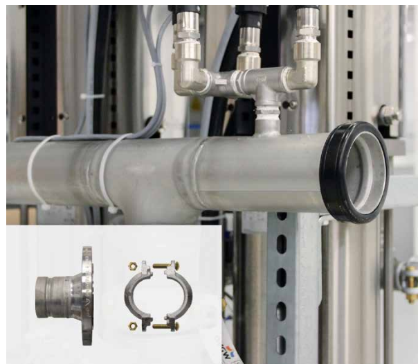
2. Vorgefetteten Dichtungsring aufstecken.
