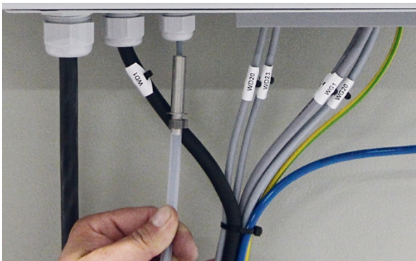
7. Das Edelstahlrohr sollte mit geeignetem Gleitmittel versehen werden und in die Durchführung geschoben werden.
