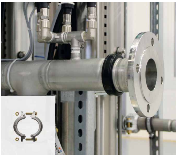
3. Flansch einfügen.
