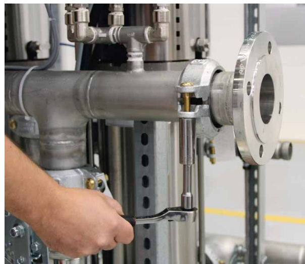
4. Kupplung auflegen und festziehen. Die Nuten der Kupplung greifen in die Rollnutnaht.
