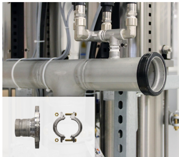
2. Vorgefetteten Dichtungsring aufstecken.
