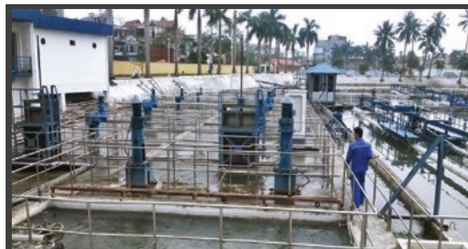
Vinh Bao Water Treatment Plant – Hai Phong Nhà máy Vĩnh Bảo tại Hải Phòng
