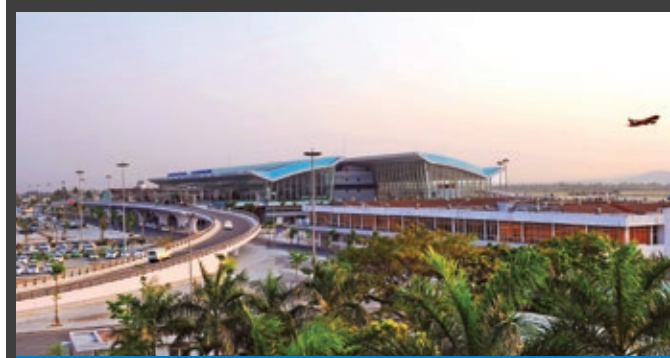
Da Nang International Airport Sân bay quốc tế Đà Nẵng
