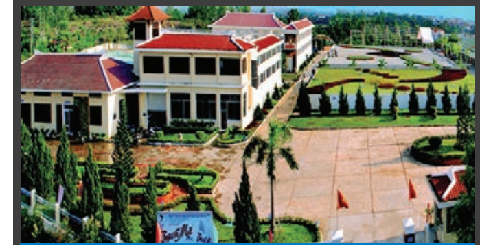
Van Nien Pumping Station Hue Trạm bơm Vạn Niên tại Huế
