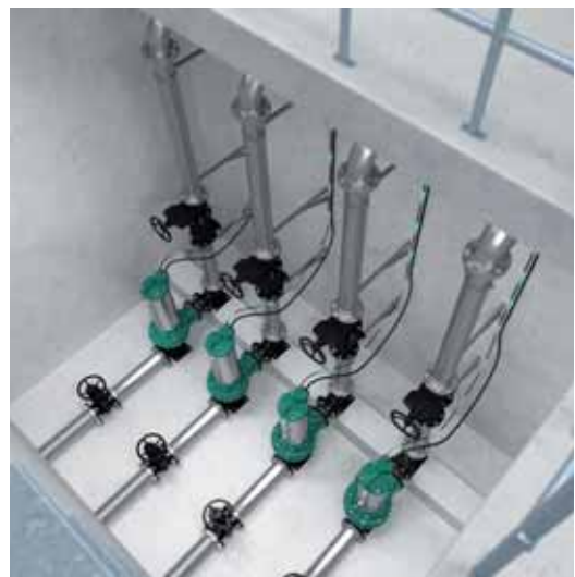
Droge opstelling / Installation en cale sèche
