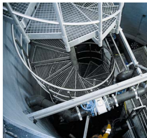
Tłocznia z PEHD (komora zewnętrzna podziemna również z PEHD) ze schodami zabiegowymi
