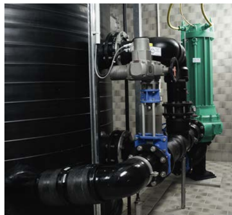
Widok zbiornika tłoczni z PEHD i jednej pompy
