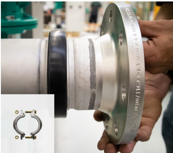
3. Flansch einfügen.
