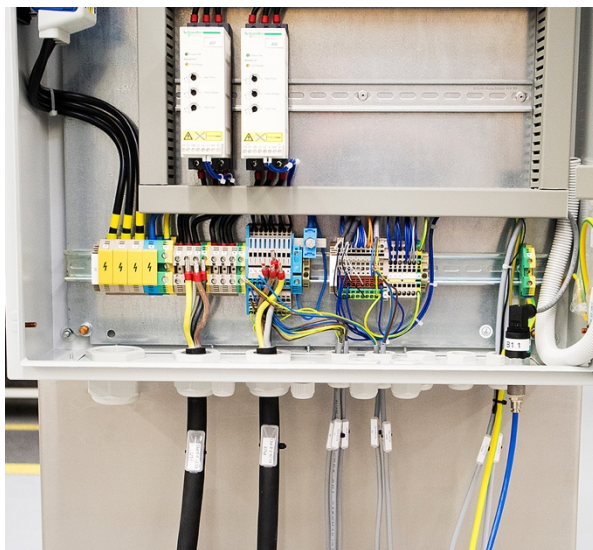
Eingeführte Kabel mit Beschriftung vorn.
