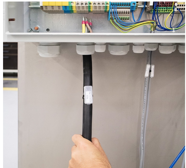
Kabel in Regelung führen.
