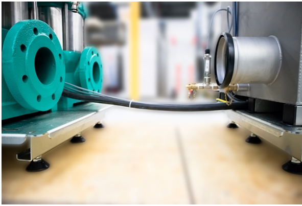
Kabelstrang zwischen Anlagenteilen.
