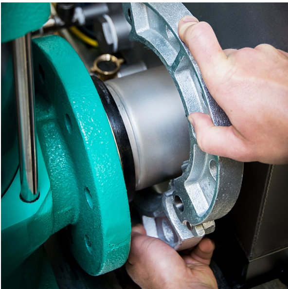
Anordnung Klappflansch auf Stutzen.
