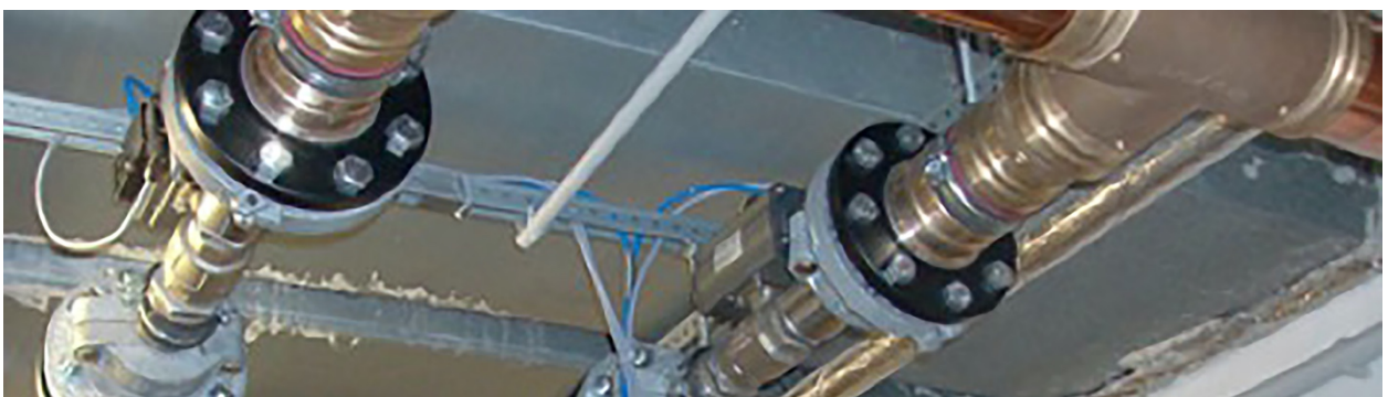
Beispielhafte Anbindung Pumpen-Notentwässerung an Entwässerungsinstallation.
