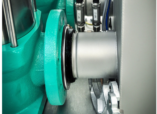
Pumpen- und Behältersegment in Endzustand schieben.
