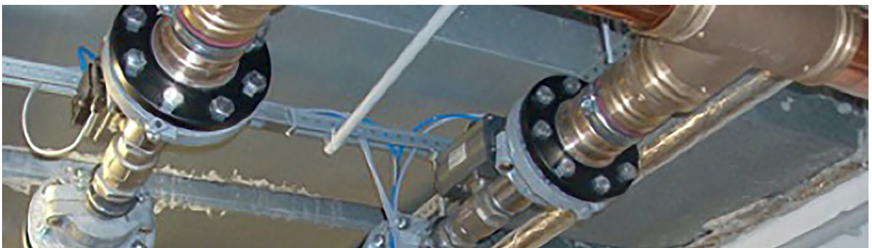
Beispielhafte Anbindung Pumpen-Notentwässerung an Entwässerungsinstallation.
