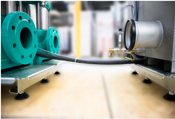
Kabelstrang zwischen Anlagenteilen.
