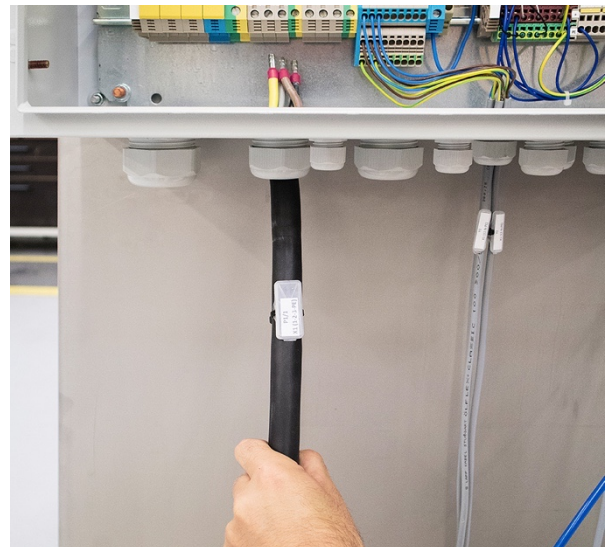
Kabel in Regelung führen.
