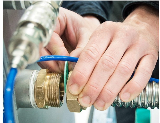
Anschluss Überströmleitung an Behälter.
